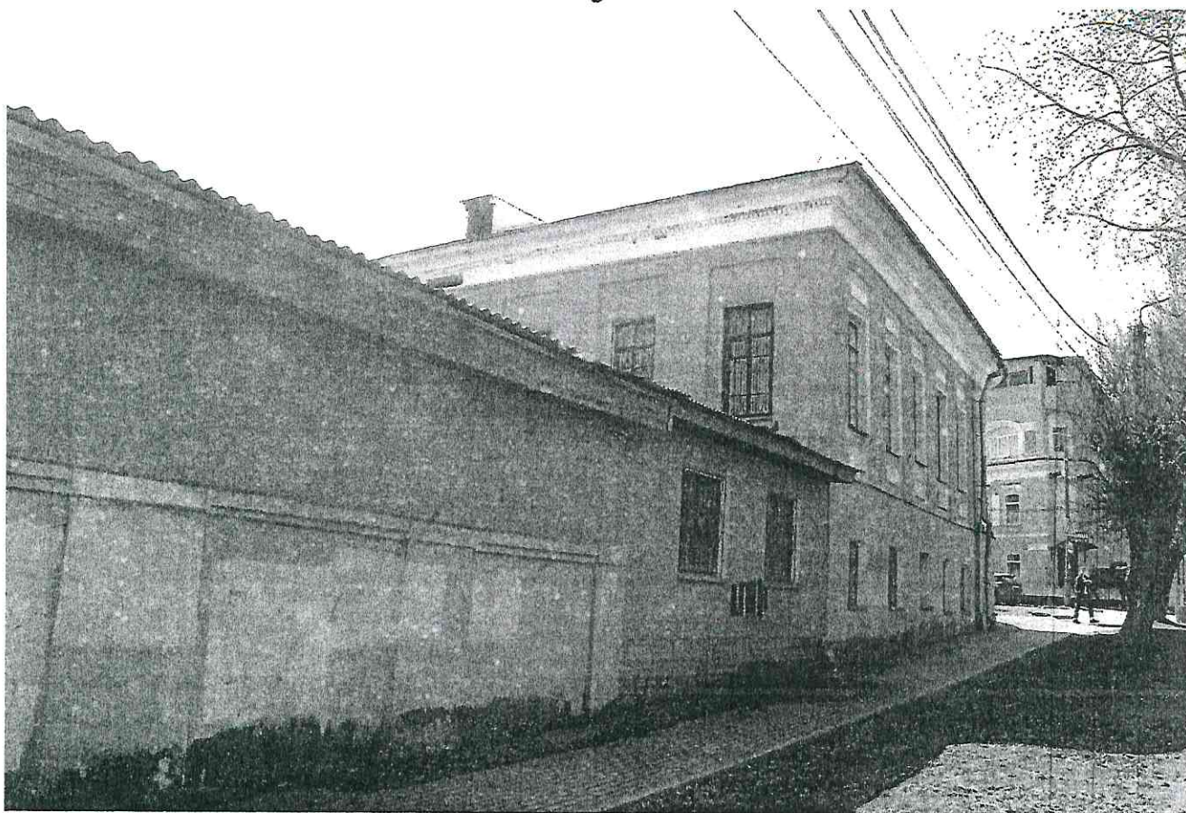
Фото № 4. Общий вид объекта культурного наследия с северо-востока. Повреждение системы водоотведения с кровли; повреждение покрытия кровли; повреждение отделочных покрытий фасадов; замокание кирпичной кладки цоколя; повреждение оконных заполнений; повреждения отмостки; поздние каменные пристрой. Фото 18.04.2023.
